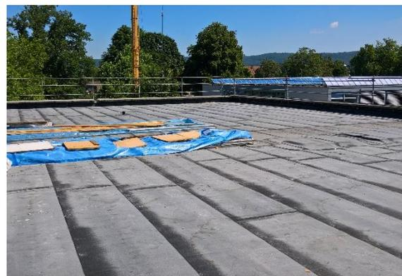
Dach abgedichtet und fur Neuaufbau vorbereitet
