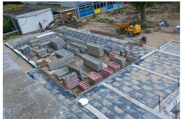
Blick auf Fundamente Neubau Bereich Atrium und Musik (bereits mit Dämmplatten belegt und mit Folie geschützt)
