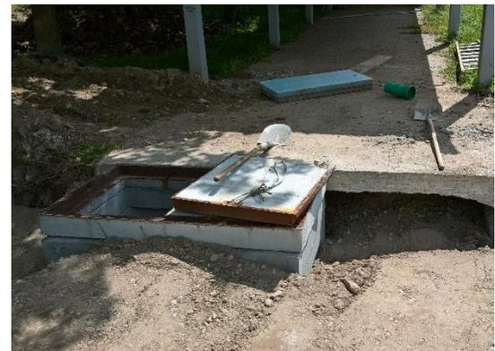
Einer von mehreren Zugschächten zur geordneten Verlegung der Elektro-Kabel
