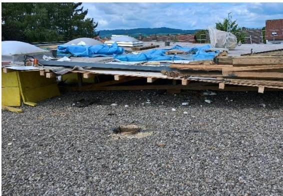
Abbau altes Bestandsdach Gebäude B, hier Reste des Dachaufbaus über Flachdach
