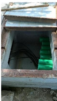
Leerrohre in Zugschacht, sämtliche Elektro-Kabel sind in Rohre geordnet verlegt
