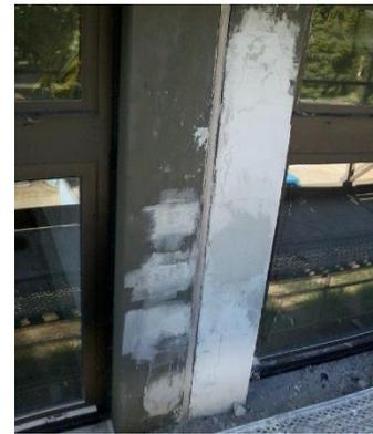
sanierte Betonstütze Gebäude B
