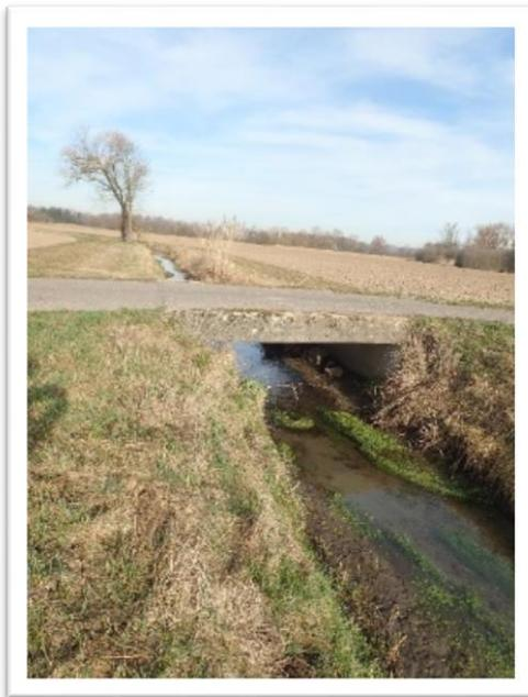
**Abb. 4: Aufnahme einer Brücke über dem Mühlbach. Diese war im ursprünglichen DGM enthalten und musste für die Simulation herausgenommen werden.**
