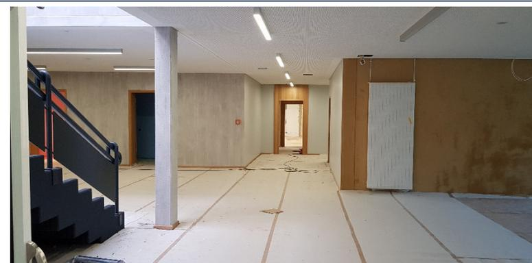
Hauptflur; Böden und Heizkörper sind mit Schutzfolien gesichert
